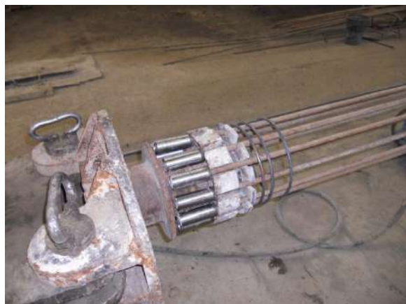
Рисунок 1 - Монтаж композитной преднапряжённой арматуры с анкерами
